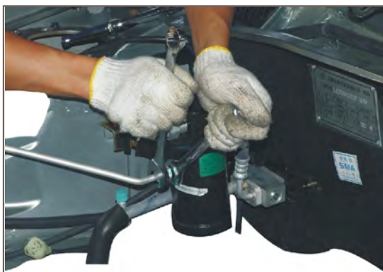
图8-14 用扳手拧紧空调管路
